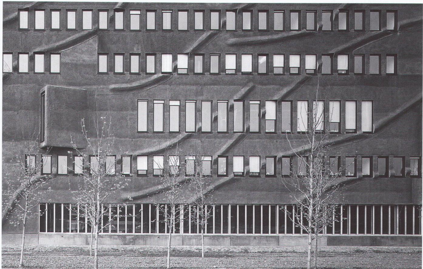
Überzüge auf dem Dach ermöglichen die stützenfreie Überspannung von 23 Metern. Die vorfabrizierten Betonelemente stammen aus dem Brückenbau. Die daruntergelegene Halle ist unbeheizt, allein in den aus der Fassadenebene auskragenden Sitznischen sind Radiatoren angebracht.
