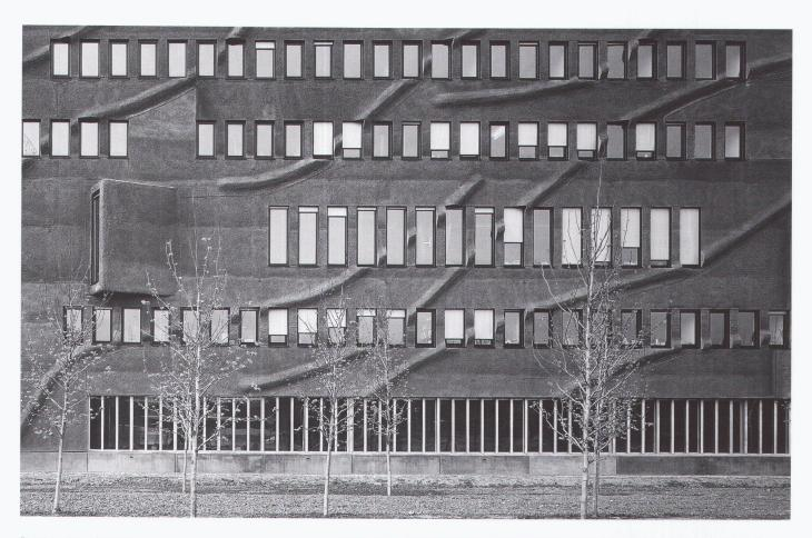
Überzüge auf dem Dach ermöglichen die stützenfreie Überspannung von 23 Metern. Die vorfabrizierten Betonelemente stammen aus dem Brückenbau. Die daruntergelegene Halle ist unbeheizt, allein in den aus der Fassadenebene auskragenden Sitznischen sind Radiatoren angebracht.
