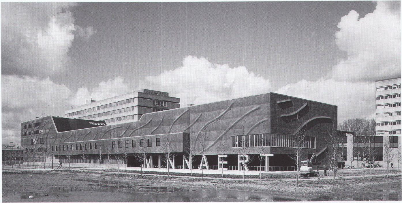
Die Außenwände sind tragend. Die grossen Öffnungen bestehen aus Hunderten von kleinen Stahlstützen, die gleichzeitig als Fensteranschläge dienen. Auch der Namenszug des belgisch-niederländischen Astronomen Minnaert ist Teil der Tragstruktur.
