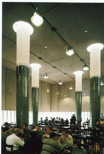
Um die Speicherkapazität des Betons nicht zu beeinträchtigen, wurde auch im Restaurant auf eine abgehängte Decke verzichtet. Die Frischluftzufuhr erfolgt statt dessen über zehn Säulen aus Lochblech und Milchglas, die zugleich als Oblichter diffuses Tageslicht spenden. Eine grosse, rote Bank dient als Lüftungskörper. Wandbekleidungen aus rotem Stoff und aus Kuhfellern erzeugen eine im Vergleich zur grossen Halle weichere Raumakustik.
