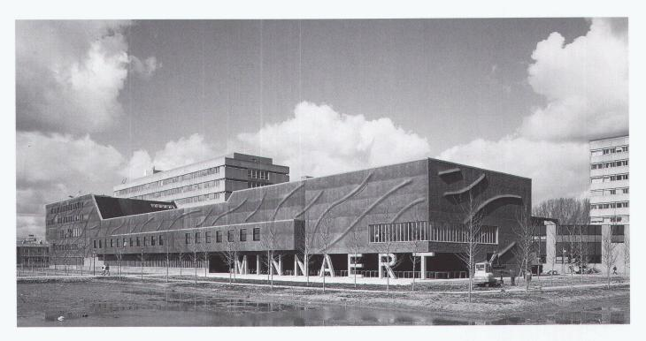
Die Aussenwände sind tragend. Die grossen Öffnungen bestehen aus Hunderten von kleinen Stahlstützen, die gleichzeitig als Fensteranschläge dienen. Auch der Namenszug des belgischniederländischen Astronomen Minnaert ist Teil der Tragstruktur. Des Les parois extérieures sont porteuses. Les grandes ouvertures comportent des centaines de petits montants en acier formant feuillures de fenêtre. Le monogramme de l'astronome belgo-néerlandais Minnaert est également intégré à la structure portante.
