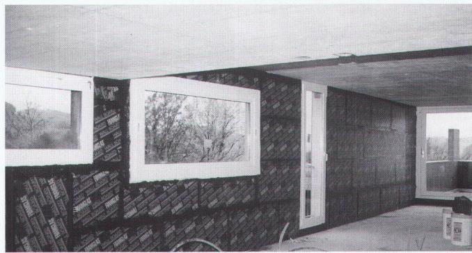
Mensch und Umwelt ist FOAMGLAS unbedenklich, denn es ist faser- und bindemittelfrei und frei von FCKW, HCFCW. Zudem enthält es keinerlei Brandschutzmittel. Da der Sicherheitsdämmstoff aus geschäumtem Glas nichtbrennbar ist (Brandkennziffer 6,3), wird Feuer im Brandfall nicht weitergeleitet. Zusätzlich von Bedeutung: FOAMGLAS ist unverrottbar, schädlingssicher, darum unverändert funktionstauglich für den ganzen Lebenszyklus und bis und mit Rückbau ökologisch einwandfrei.
