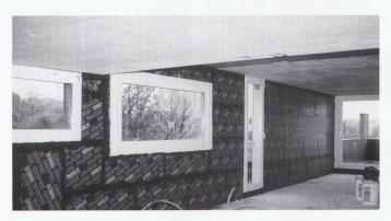
Mensch und Umwelt ist FOAMGLAS unbedenklich, denn es ist faser- und bindemittelfrei und frei von FCKW, HFCKW. Zudem enthält es keinerlei Brandschutzmittel. Da der Sicherheitsdämmstoff aus geschäumtem Glas nichtbrennbar ist (Brandkennziffer 6.3), wird Feuer im Brandfall nicht weitergeleitet. Zusätzlich von Bedeutung: FOAMGLAS ist unverrottbar, schädlingssicher, darum unverändert funktionstauglich für den ganzen Lebenszyklus und bis und mit Rückbau ökologisch einwand-
