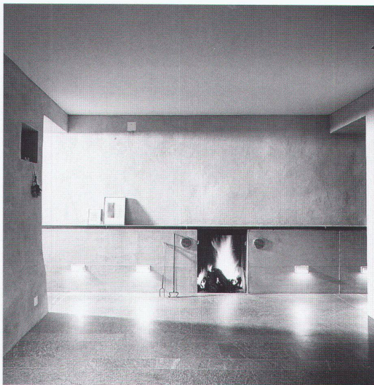
Vormauerung mit Kamin und Fussbodenbeleuchtung
