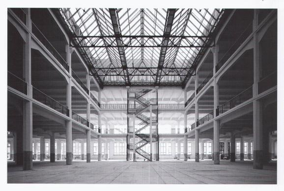
Die Rohbaustruktur des Stahlbetonskelettbaus blieb erhalten wie die Abfolge von Lichthöfen. Die Einbau-ten erfolgten nach dem Prinzip der Trennung des Neuen vom Alten durch eine Verselbständigung der Einbauten.
