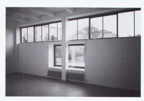
Der geänderten Nutzung von Büroräumen im Untergeschoss und Wohnungen im Obergeschoss ent-sprechend wurden zusätzliche neue Ferrassentüren und Fenster in Augenhöhe angebracht, während die seinerzeitigen Warteräume der Arbeitssuchenden lediglich Ober-lichtbänder aufwiesen. Die neuen Öffnungen sind identisch, unter-scheiden sich innen und aussen deutlich vom Originalzustand und
