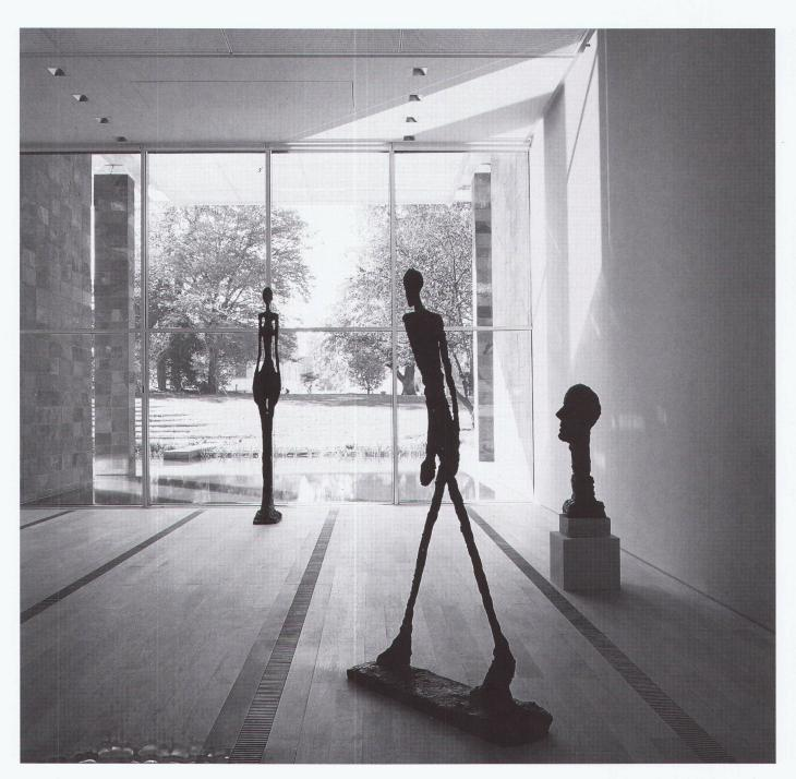
Die Fassade mit raumhohen Ver-glasungen ist eine Pfostenriegel-konstruktion; die Pfosten bestehen aus Flachstahlprofilen mit Schattenfuge.
