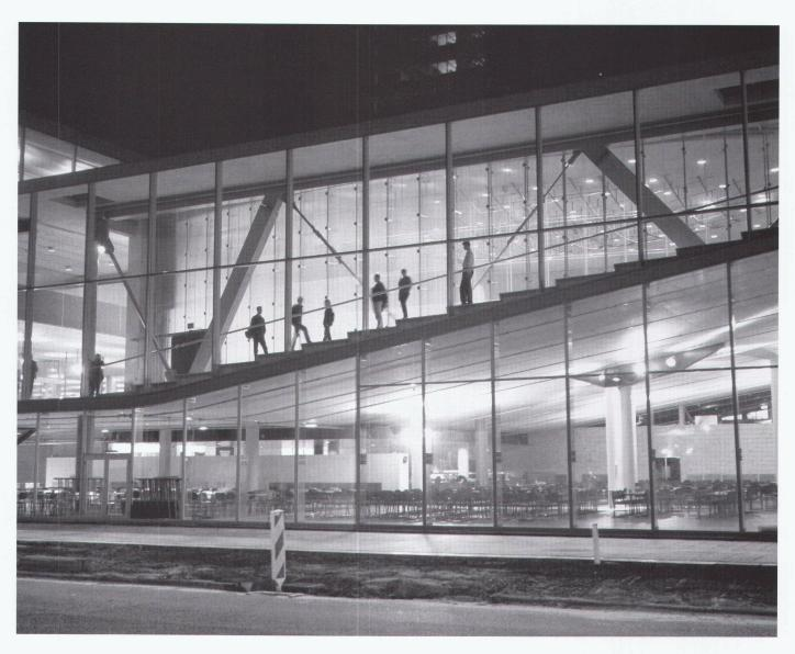
Ein geschosshoher Fachwerkträger mit Zugstangen aus Stahl und Druckstäben aus Beton ermöglicht in der darunterliegenden Kantine eine unregelmässige Stützenstellung mit einer maximalen Spannweite von mehr als dreissig Metern.
