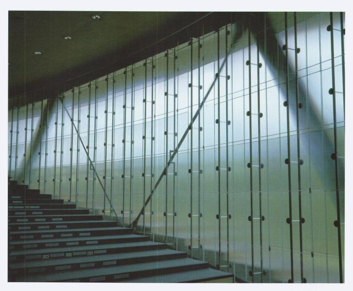
Die doppelte Glashaut zwischen dem grossen Hörsaal und der grossflächig verglasten Nordfassade enthält eine holographische Folie. Sie ist transparent, sofern man frontal hindurchschaut. Je flacher aber der Blickwinkel wird, desto mehr verschleiert sich das Bild: Personen, die auf der anderen Seite entlanggehen, tauchen wie aus entlanggehen, tauchen wie aus dem Nebel auf, sind für einen kurzen Moment deutlich erkennbar und verschwinden wieder.
