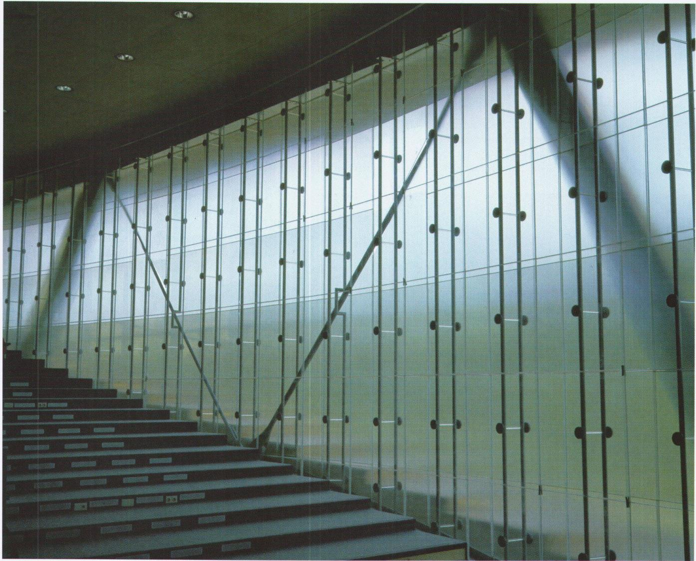
Die doppelte Glashaut zwischen dem grossen Hörsaal und der grossflächig verglasten Nordfassade enthält eine holographische Folie. Sie ist transparent, sofern man frontal hindurchschaut. Je flacher aber der Blickwinkel wird, desto mehr verschleiert sich das Bild. Personen, die auf der anderen Seite entlanggehen, tauchen wie aus dem Nebel auf, sind für einen kurzen Moment deutlich erkennbar und verschwinden wieder.
