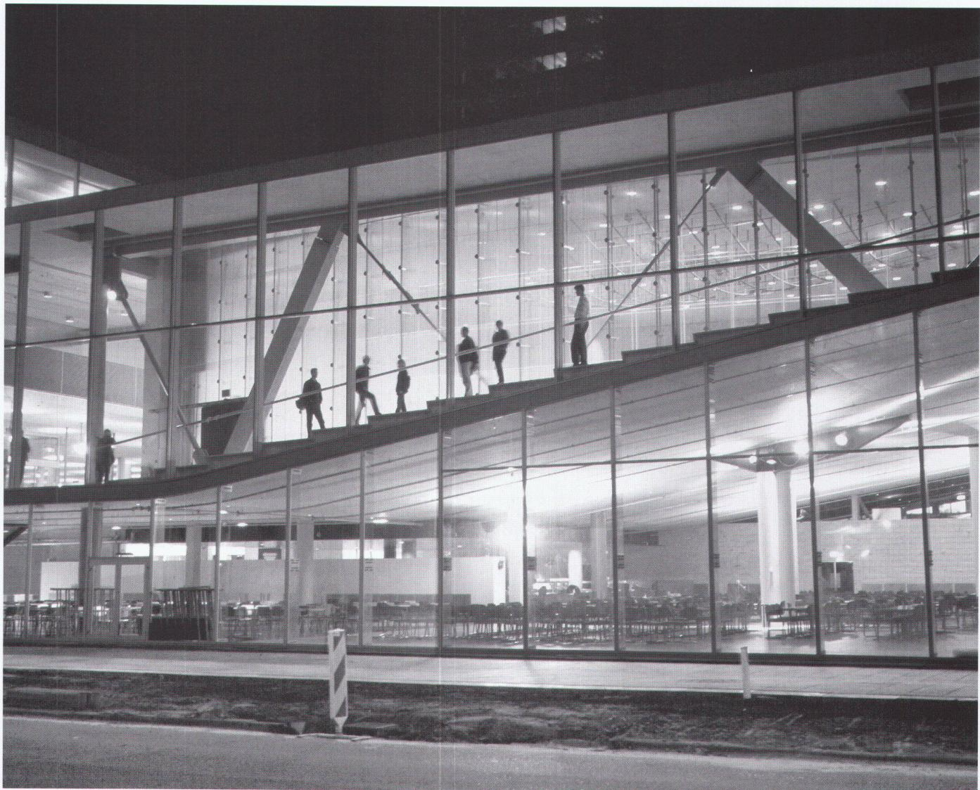
Ein geschosshoher Fachwerkträger mit Zugstangen aus Stahl und Druckstäben aus Beton ermöglicht in der darunterliegenden Kantine eine unregelmäßige Stützenstellung mit einer maximalen Spannweite von mehr als dreissig Metern.
