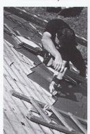
besteht aus montagefertig gelieferten, 40×40 cm messenden Quartz-Zinc-Elementen und einem Zubehörsortiment, das alle für die Montage erforderlichen Teile umfasst. Die Montage sollte vorzugsweise einem Spengler übertragen werden, der den Umgang mit Material wie Zink gewohnt ist. Das System erlaubt schnelles und unkompliziertes Arbeiten: Element einlegen, an drei Punkten verschrauben, fertig! Auf den Quadratmeter entfallen weniger als zehn Elemente.
