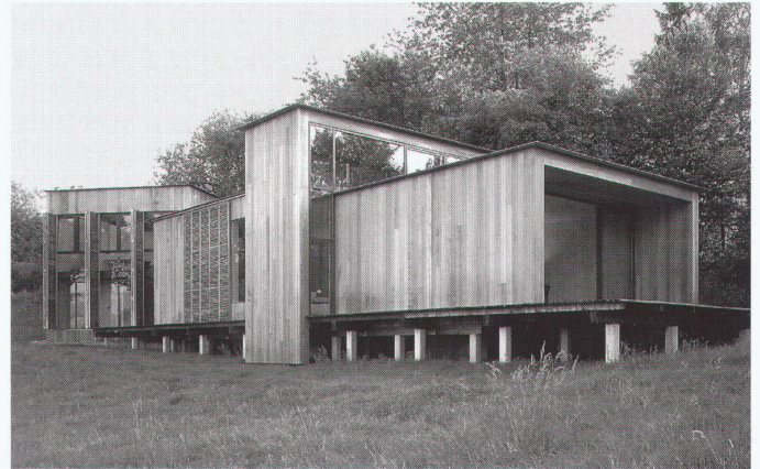
Ansicht von Osten
