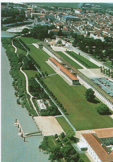
Gesamtanlage ■ Vue d'ensemble ■ General view
