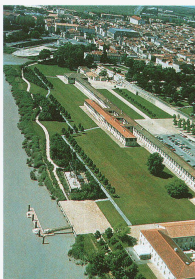
Gesamtanlage ■ Vue d'ensemble ■ General view
