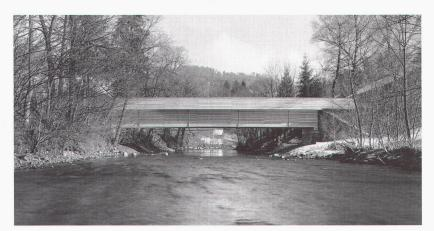
sche Grundlage für Konstruktion und Ausdruck der Brücke. Die Tragstruktur ist nach einem einfachen additiven Prinzip in einem kompakten Gefüge aus Balken, Bohlen, Platten und Brettern verdichtet und tritt zugunsten eines kraftvollen Brückenkörpers in den Hintergrund. Die Gestik des asymmetrischen Querschnitts und des seitlich ausladenden Gehstegs gibt der Brücke ihren eigenen, ortsspezifischen Cha-
