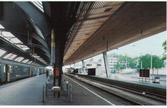
beim Dachkörper ebenfalls zum Tragen: seine gebrochene Transparenz macht ihn zu einer Art «Lichtkammer» (ein Kompromiss erzwang die nach unten gerichteten Scheinwerfer als kostengünstige Ergänzung zur inneren Ausleuchtung des Hohlraums). Strukturell entsprechen dem medienführenden Dachraum die vorfabrizierten Betonstützen, deren Hohlträgerquerschnitt die vertikale Leitungsführung aufnimmt.
