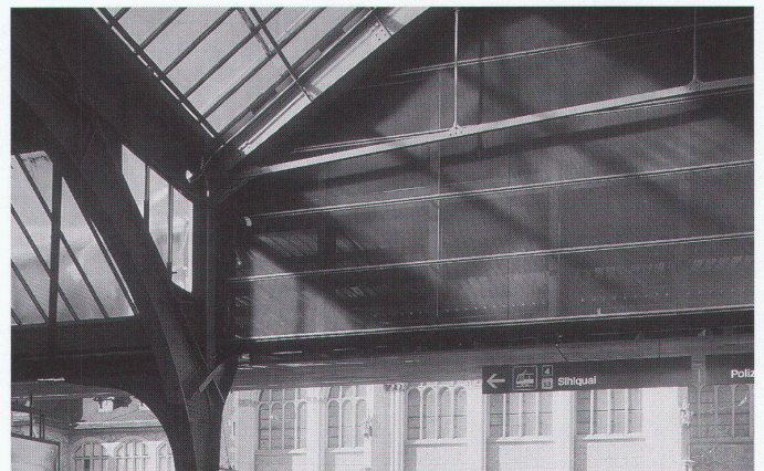
Innenansicht Querhalle: Anschluss Dachkörper ■ Élévation intérieure du hall transversal: attachement du volume toit ■ Interior elevation in concourse: connection of roof volume
