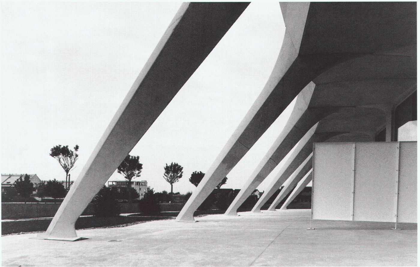
Eingangsbereich ■ Zone d'entrée ■ Entry area
