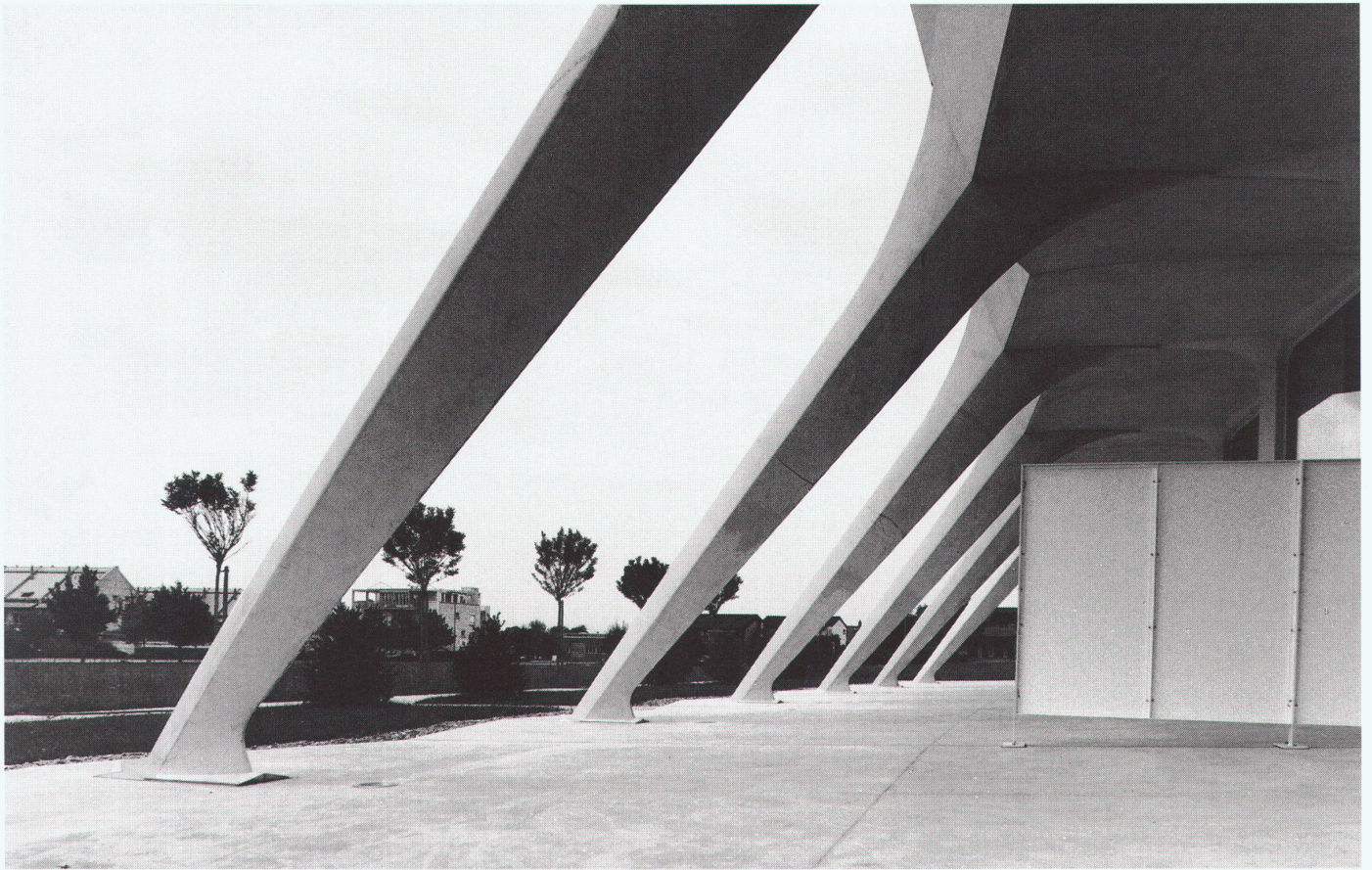
Eingangsbereich ■ Zone d'entrée ■ Entry area
