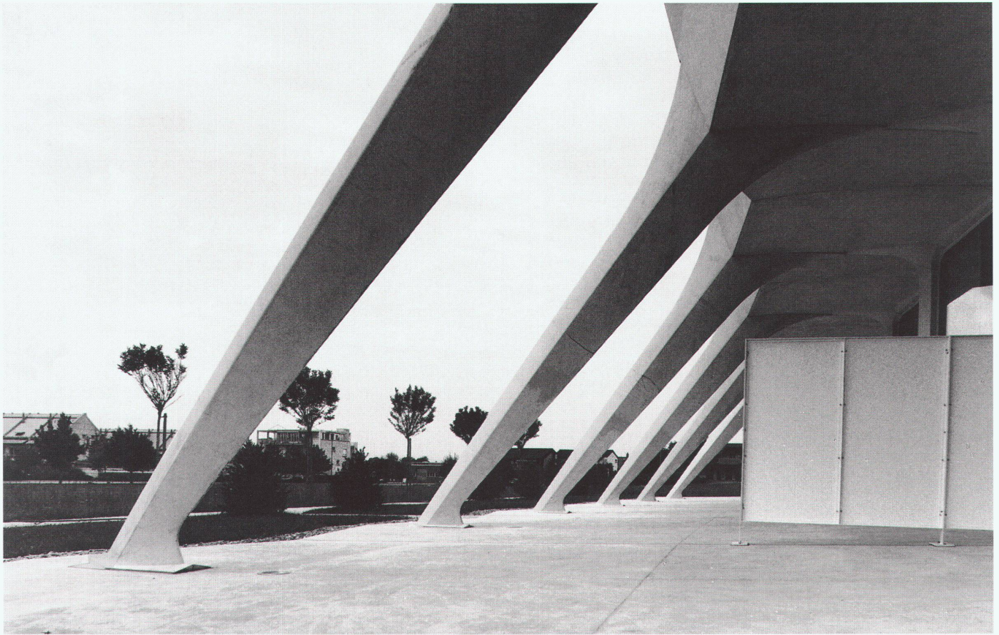
Eingangsbereich ■ Zone d'entrée ■ Entry area
