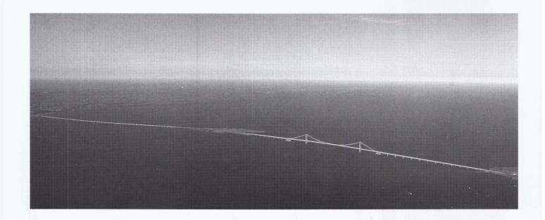
Aufgrund der grossen Spannweite und der Wirtschaftlichkeit eines relativ grossen Kabeldurchhangs sind die Pylone sehr hoch (26 Meter höher als bei der Golden Gate Bridge).
