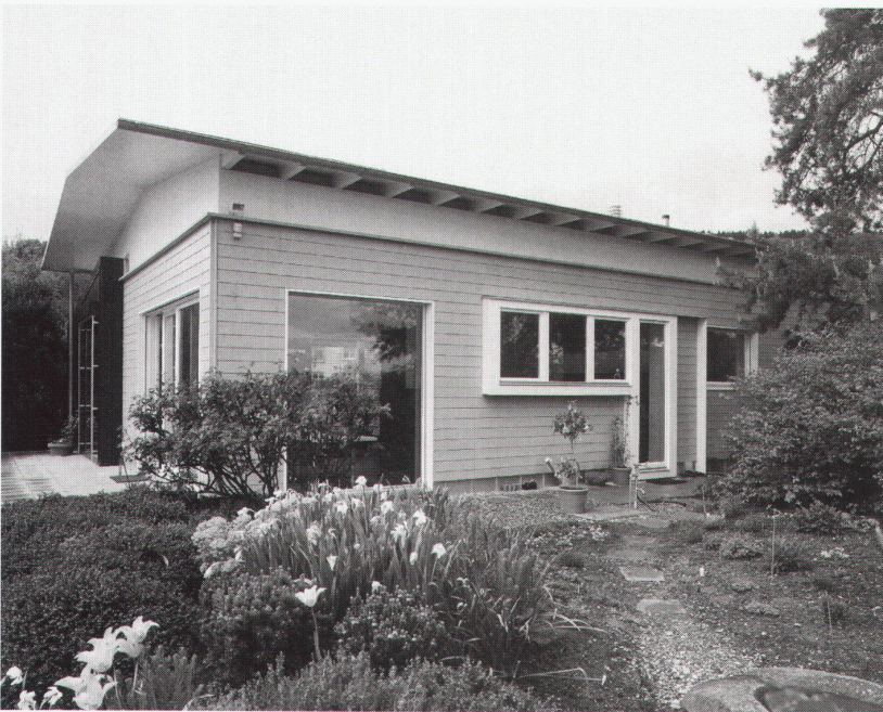
Südfassade Façade sud
