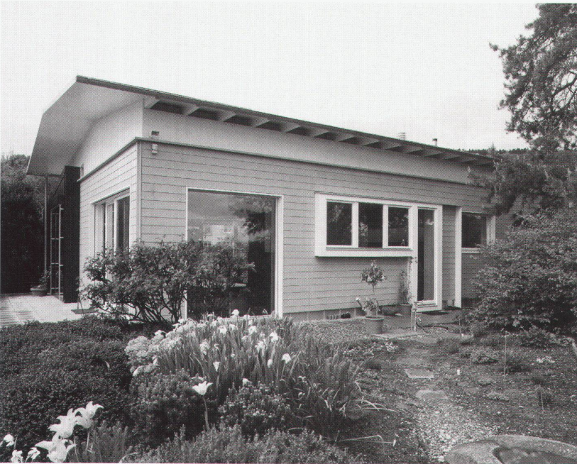
Südfassade Façade sud
