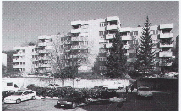
Ansicht von Westen vor und nach der Sanierung ■ Vue de l'ouest avant et après rénovation ■ View from the west before and after restoration
