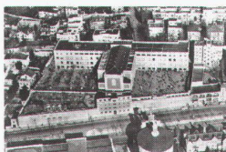
Flugbild des Gymnasiums vor dem Ein- und Umbau ■ Vue aérienne du lycée avant aménagement et transformation ■ Aerial view of the high school before conversion and installation
