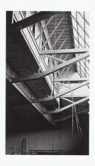
senkrecht auf sie zulaufenden Bogenlinie. Diese Schräge bringt Licht in die Tiefe der Halle und ermöglichte es, den Grundriss als quasi symmetrische Dreiteilung mit «Hauptschiff» und »Seitenschiffen» zu entwickeln.
