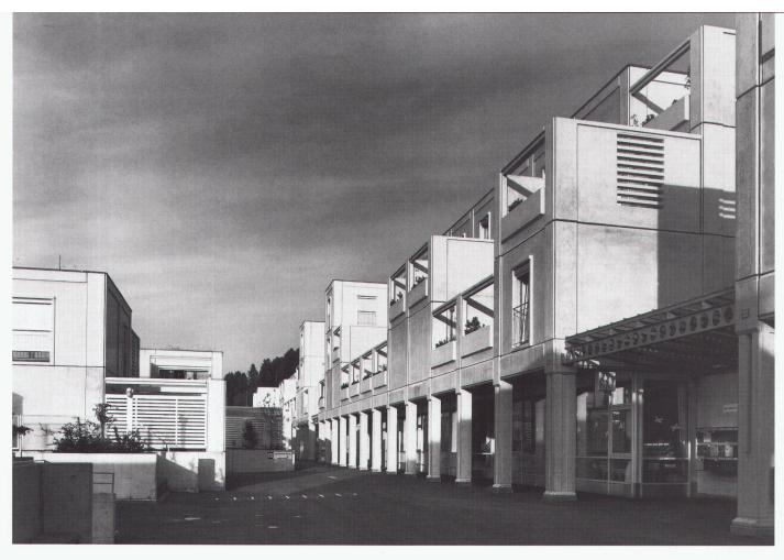
Charakter dieser Zellstruktur bekommt durch die freie Kombination ihrer Komponenten in horizontaler und vertikaler Richtung individuellen Ausdruck. Der Planungsraster, im Grundriss 3,90 m × 3,90 m und in der Höhe 2,75 m, ist Basis für das virtuelle statische Raumgitter, das sich über die ganze Siedlung hinzieht.
