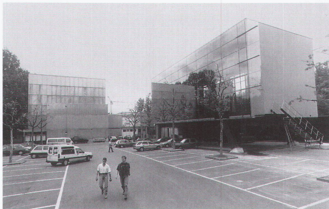
Tragstrukturen im Alt- und Neubau ■ Structures portantes du bâtiment existant et de l'addition ■ Structures of existing and new building
