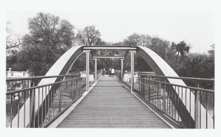
Die Breite der Brücke und die Geländer verengen sich fast unmerk-lich zur Mitte, so dass in der Per-spektive des Benutzers der Weg zum Ufer kürzer erscheint. Die Gehwegfläche hat zur Mitte einen leichten Durchhang (25 cm), so dass, auch wenn viele Leute auf der Brücke sind, von den Ufern ein guter Überblick möglich ist (analog einem Theaterparkett).
