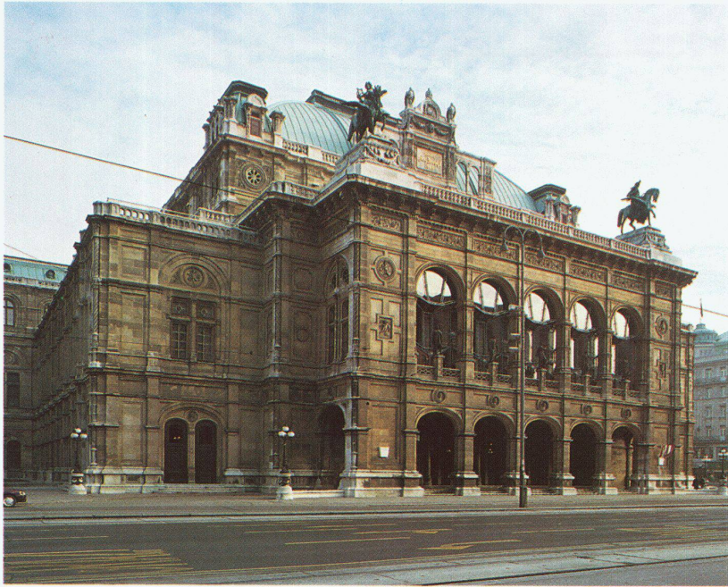
Winterverglasung der Loggia der Wiener Staatsoper; Fassadentechnik: AFC, Wien; Statik: Peter Kotzian, Wien, 1991–1994
