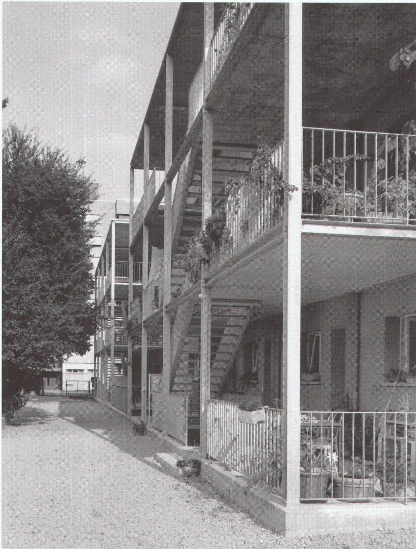
Wohnsiedlung Muracker, Lenzburg, 1993–1995 Architekten: Felix Kuhn, George Pfiffner, Aarau Mitarbeit: Niklaus Widmer
