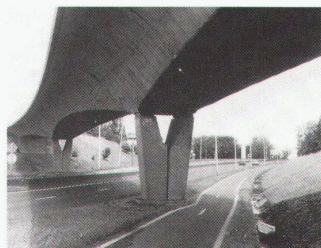
Le pont de l'autoroute sur la route nationale à Orly; architecte: Henri Vicariot, ingénieur: Jean Gaillard, 1958
