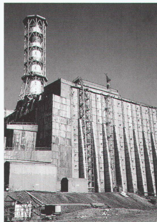
Baufaufnahme 1986: Einfüllen von Beton in Stahlcaissons der Sarkophag-Nordfassade
