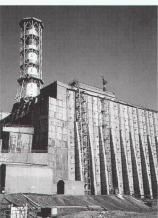
Bauaufnahme 1986: Einfüllen von Beton in Stahlcaissons der Sarkophag-Nordfassade
