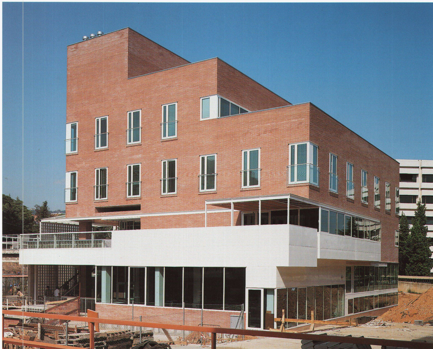
Ansicht von Süden ■ Vue du sud ■ View from the south
