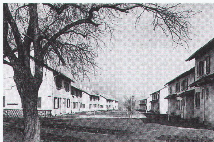
Wohnsiedlung «Mattenhof», Zürich-Schwamendingen, 1946–1947; Architekten: O. Becherer, W. Frey, O. Dürr, K. Kündig Durchblick durch einen begrünten Zwischenraum
