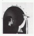
der ebenfalls vorhandenen Gipskartonsäge ausgesägt. Nun wird die Gipskartonplatte auf dem Ständerwerk befestigt und die mitgelieferten Edelstahlklammern werden im Abstand von 10 cm auf die Rundung der ausgeschnittenen Platte aufgesteckt, Schliesslich wird der Streckmetallstreifen in die Laibung eingelegt und die Klammern mit dem Kunststoffprofil so abgedeckt, dass eine saubere Kante entsteht, bevor der Innenwandputz aufgebracht werden kann. Korff AG, 4538 Oberbipp
