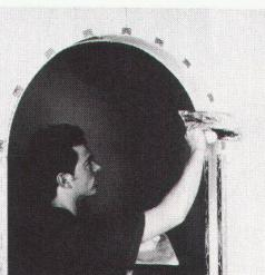
der ebenfalls vorhandenen Gipskartonsäge ausgesägt. Nun wird die Gipskartonplatte auf dem Ständerwerk befestigt und die mitgelieferten Edelstahlklammern werden im Abstand von 10 cm auf die Rundung der ausgeschnittenen Platte aufgesteckt. Schliesslich wird der Streckmetallstreifen in die Laibung eingelegt und die Klammer mit dem Kunststoffprofil so abgedeckt, dass eine saubere Kante entsteht, bevor der Innenwandputz aufgebracht werden kann. Korff AG, 4538 Oberbipp
