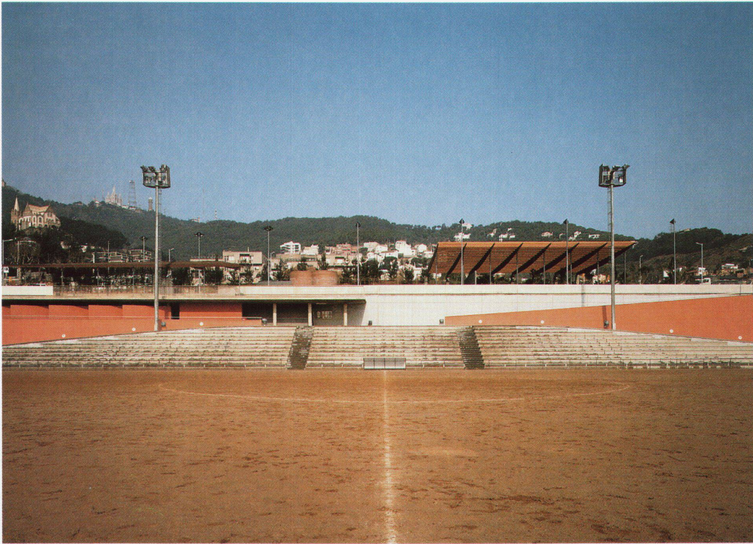
Tribüne von Südosten ■ Les tribunes vues du sud-est ■ The grandstand from the southeast
