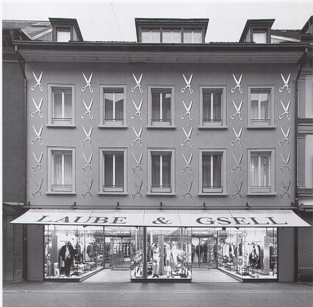
Ansicht Fassade Vue de la façade
