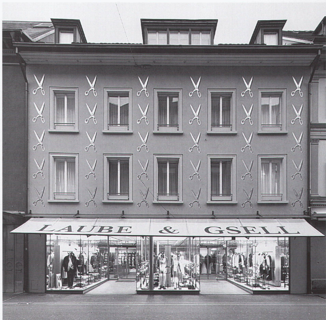
Ansicht Fassade Vue de la façade
