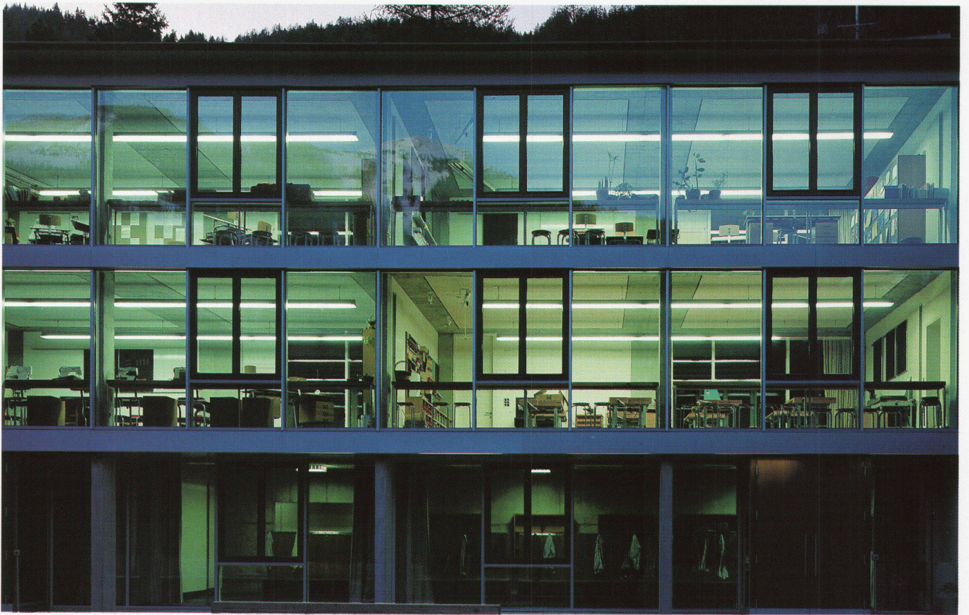
Ansicht von Westen, bei Nacht ■ Vue de l'ouest la nuit ■ View from the west, night view
