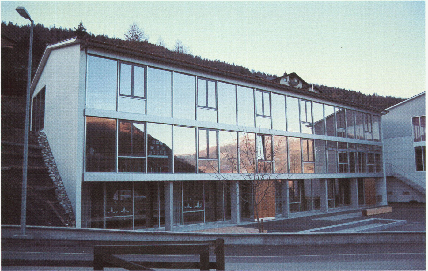
Ansicht von Westen, bei Tag ■ Vue de l'ouest le jour ■ View from the west, daytime
