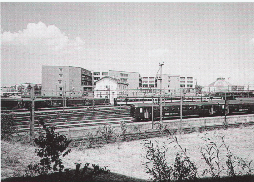
Ansicht von Süden Vue du sud View from the south
