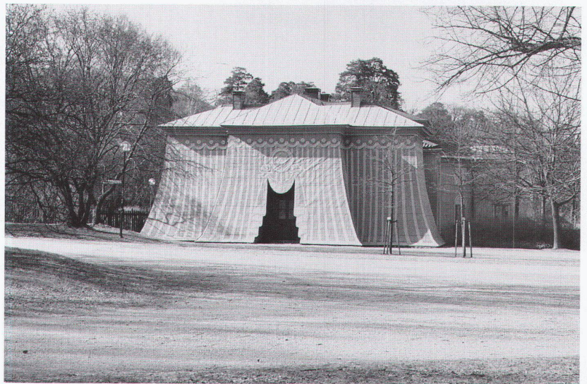
Die «Kupferzelte» im Park von Haga, im Norden von Stockholm Architekt: Louis Jean Desprez
