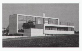
müssen natürlich auch die richtigen Profile eingesetzt werden. Mit dem therm® clima-System der Firma Herrmann Forster AG, Stahlrohrtechnik, wurde die optimale Lösung gefunden. «So lässt sich Transparenz in Stahl bei extrem guter Wärmedämmung realisieren», erklärt Gabriele De Nardi. Als Marketingleiter weiss er um die Wichtigkeit der sensationellen K-Werte zwischen 1,5 und 1,8. «Jeder Metallbauer weiss das heute schon zu schätzen. Und in Zukunft wird dies noch wichtiger werden.»
