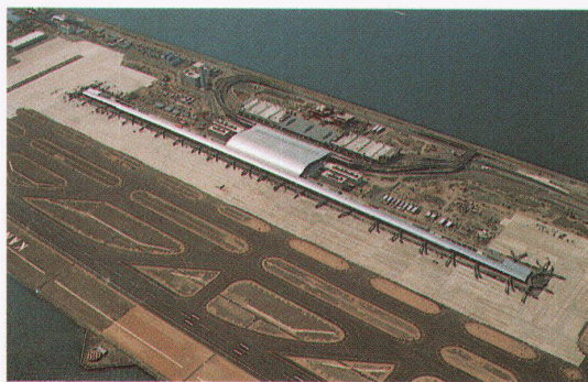
Luftbild des neuen Flughafens
