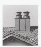
Strömungsverhältnisse in und über dem Kamin. Die Luft über der Kaminmündung wird in eine laminare Strömung geleitet. Dies hat auf den aufsteigenden Rauch einen entscheidenden Einfluss. Er wird dadurch permanent unter Kontrolle gebracht, Der kontrollierte Rauchgasabzug wiederum wirkt zurück auf seinen Ausgangspunkt (z.B. Cheminée oder Brenner usw.) und schafft so ausgleichende Verhältnisse im Energieverbrauch. In einer Heizungsanlage kommt dieser Vorteil besonders zum Tragen.
