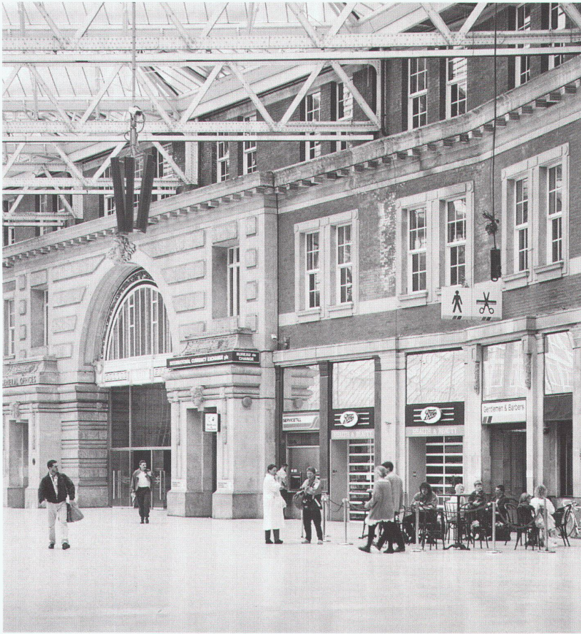
Alte Bahnhofshalle mit neuem Glasdach
