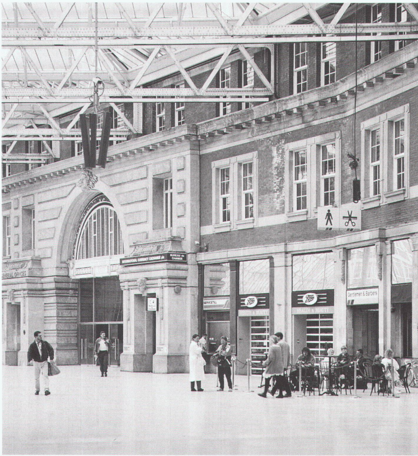
Alte Bahnhofshalle mit neuem Glasdach
