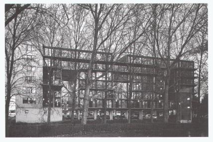
Das Gebäude befindet sich auf einem Streifen zwischen einer Reihe paralleler landschaftlicher Elemente wie Strasse, Baumreihe, Kanal und Deich, welche den Übergang zwischen Wohn- und Grünzone bilden. Die Situation spiegelt sich im Entwurf des Gebäudes wider: Die Strassenfassade besteht aus einer Scheibe aus Stein, welche die Wohnzone aus «lebenden» Materialien (Holz, Glas und Wellblech) kontrastiert. Die Fassade gegen die Grünzone weist ausschliesslich Verglasungen und Balkone auf.
