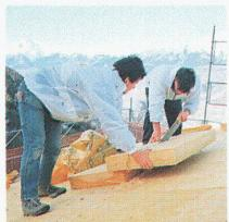
Nach dem Markieren wird der TAFIXE mit einigen Hammerschlägen in der Dämmsschicht fixiert. Seine genau der Dicke des Dämmstoffs entsprechende Höhe sorgt für eine ausgezeichnete Ebenheit des Daches.
