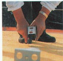
Durch das obere Loch des TAFIXE werden die Konterlatten ohne Vorbohren maschinell in die Sparren eingeschraubt. Das zweite Loch erlaubt die solide Verbindung von zwei Konterlatten.
