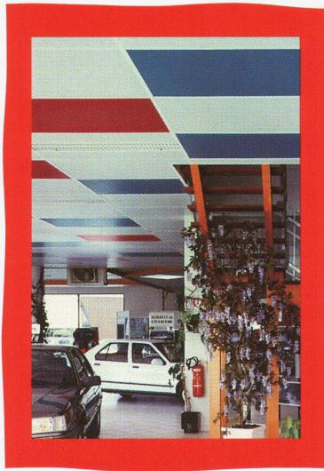
Die aluminiumbeschichteten Industriedeckenplatten aus Glas- oder Steinwolle dienen zur Wärmedämmung hinterlüfteter Decken. Sie eignen sich besonders für Industrie- und Geschäftsräume sowie Lager- und Ausstellungshallen.
