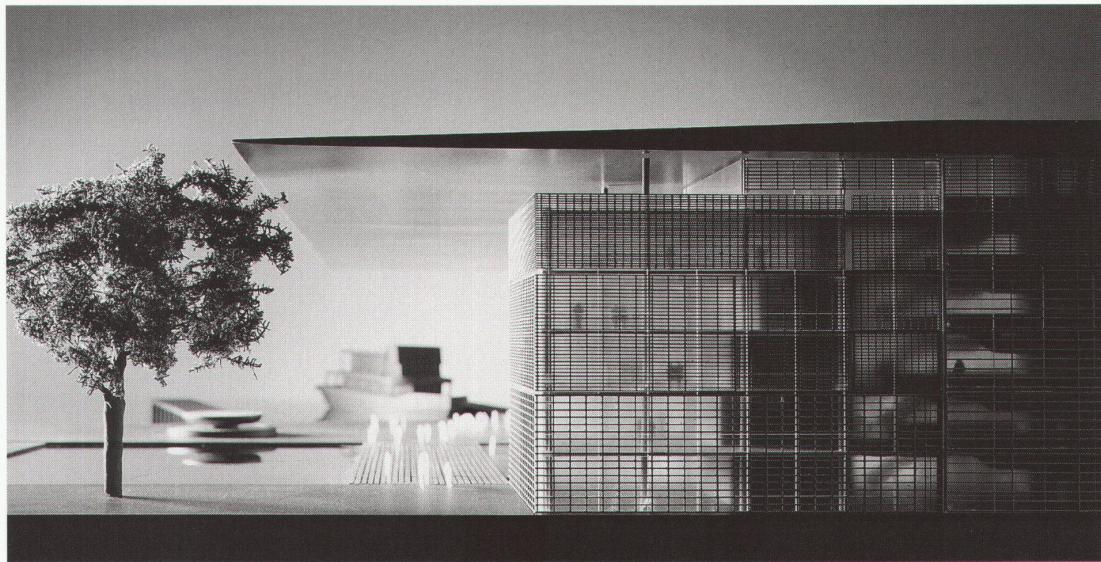
Blick vom Bahnhofplatz auf den vorderen Teil der Westfassade, hinter dem sich wie in einem verglasten Bug Cafeteria und Restaurant befinden. Die Westfassade besteht aus zwei Schichten, einer inneren verglasten und einer äusseren, die als patchworkartig perforierte Metallhaut ein Abbild der verschiedenartigen Nutzungen des Kongress-/Museumstraktes gibt und den Lichteinfall steuert. Vor der seeseitigen Fassade erkennt man das von einer Brücke überquerte künstlich geschaffene Wasserbecken.
