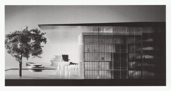
Blick vom Bahnhofplatz auf den vorderen Teil der Westfassade, hinter dem sich wie in einem verglasten Bug Cafeteria und Restaurant befinden. Die Westfassade besteht aus zwei Schichten, einer inneren verglasten und einer äusseren, die als patchworkartig perforierte Metallhaut ein Abbild der verschiedenartigen Nutzungen des Kongress-/Museumstraktes gibt und den Lichteinfall steuert. Vor der seeseitigen Fassade erkennt man das von einer Brücke überquerte künstlich geschaffene Wasserbecken.
