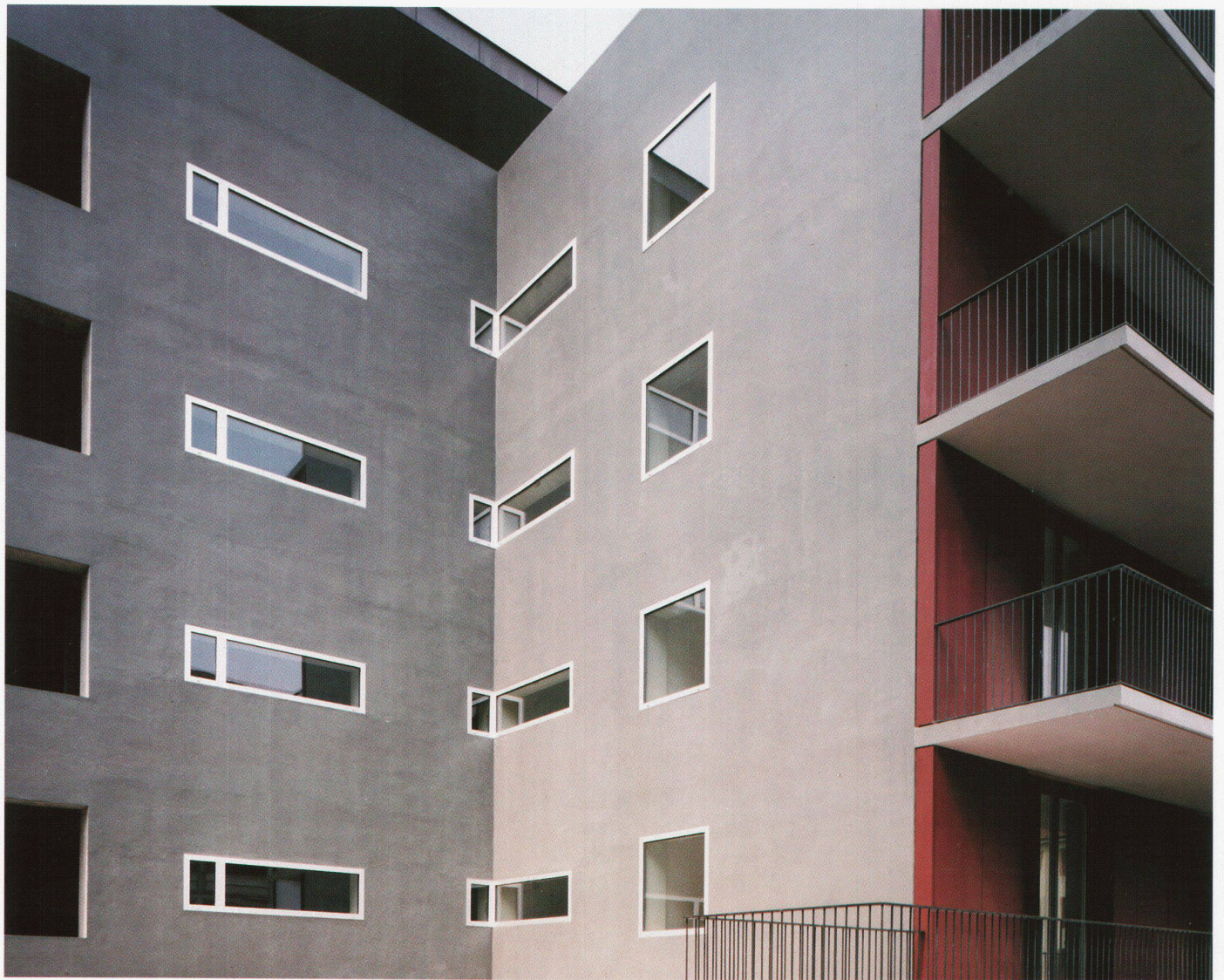
Fassadendetail von Südosten Détail de façade vu du sud-est Detail of the façade view from the southeast
