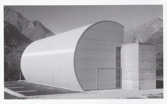
Das Atelier ist als Behälter mit zwei klar unterschiedenen Teilen ausgebildet. Ein prismatischer Betonkörper mit Lager und Nasszellen im Erdgeschoss und einer Ausstellungsgalerie im Obergeschoss greift längsseits unter die zylindrische, mit blauem Wellblech verkleidete Metallstruktur des Arbeitsraums. Vom Eingang her wird der Innenraum in der Gesamtheit seiner Elemente einsichtig.
