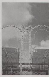
Martorell, Bohigas, Mackay: Pavillon der Zukunft (Pabellón del Futuro), Sevilla, 1992 In jedem Primärbogen ist ein Ring mit kurzen Stahlstangen abgehängt. Die sternförmige Anordnung der Stangen zwischen dem Stahlzugring und dem Steinbogen garantieren eine beinahe perfekte Belastung.
