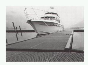
Querstab eingepresst wird, macht die konstruktive Besonderheit dieses Gitterrostes aus. Um eine optimale Verbundwirkung zu erzielen, stehen die Trag- und Querstäbe in einem bestimmten metallurgischen Verhältnis.
