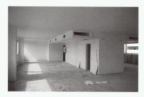
Die frei unterteilbaren Büros sind auf die Leitungsführung der Klima-anlage abgestimmt. Sie bilden einen offenen Raum, der durch die ver-tikale Luftzirkulation zoniert und wegen der unterschiedlichen Raumhöhen – ja nach Lage der Lüftungs-kanäle – nuanciert ist.
