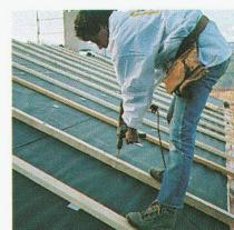
Die Platten LURO HDF 614 werden lückenlos auf der ganzen Dachfläche verlegt, was Wärmebrücken beseitigt und eine optimale Dämmung sicherstellt.
