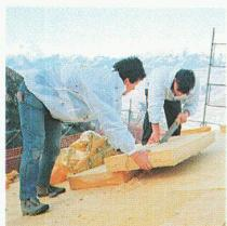
Nach dem Markieren wird der TAFIXE mit einigen Hammerschlägen in der Dämmsschicht fixiert. Seine genau der Dicke des Dämmstoffs entsprechende Höhe sorgt für eine ausgezeichnete Ebenheit des Daches.
