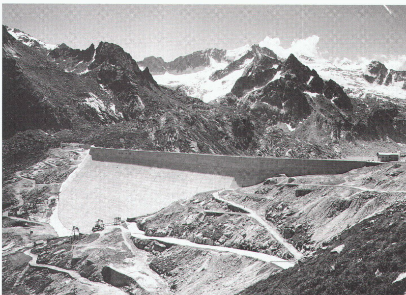
Albignawerk Löbbia, 1959. Das Gewichtstaumauerwerk ist 115 m hoch, die Kronenlänge beträgt 750 m. Die 43 Betonblöcke sind je 20 m breit und 80 m tief.
