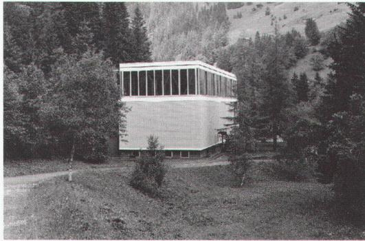
**Maschinenhaus in Thusis, 1899.** Nachdem 1950 ein Felssturz den bergseitigen Teil des Maschinenhauses zerstört hatte, wurden die Wände schräg und mit abgerundeten Ecken ausgebildet. Heute wird das Gebäude als Lagerhalle (mit zugemauerten Fenstern) benützt.
