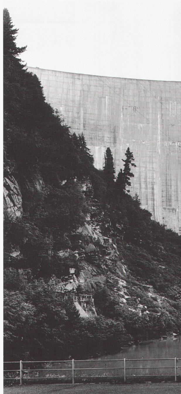
**Seewerk Zervreila, 1958.** Die Bogenmauer (150 m hoch und 480 m lang) staut 100 Millionen Kubikmeter Wasser. Dem Seewerk wurde das Dörfchen Zervreila geopfert. Die Seewerkzentrale besteht aus Betonscheiben, die einfachverglaste Stahlfenster sind innen grün und aussen rot.
