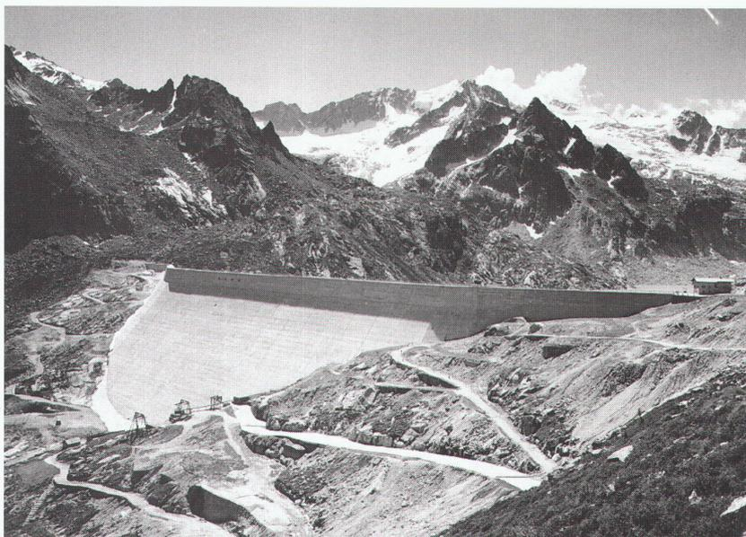
**Albignawerk Löbbia, 1959.** Das Gewichtstaumauerwerk ist 115 m hoch, die Kronenlänge beträgt 750 m. Die 43 Betonblöcke sind je 20 m breit und 80 m tief.
