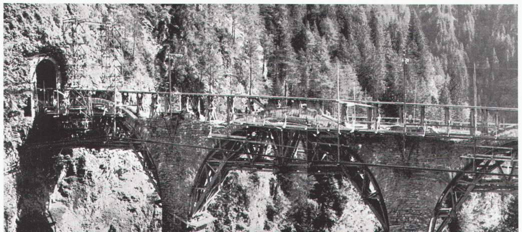
Castieler Viadukt während des Umbaus Viaduc de Castiel pendant sa transformation Castiel Viaduct during renovation
