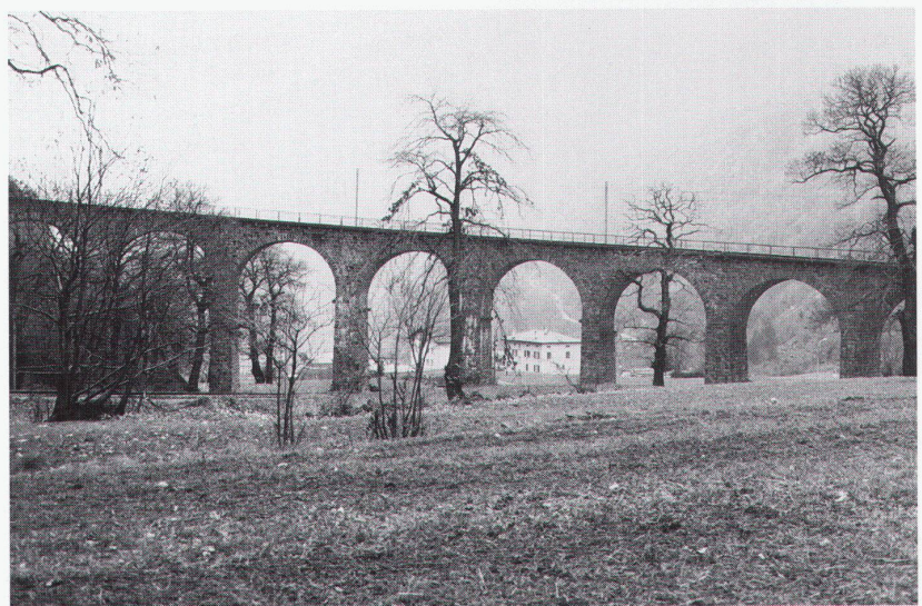
Kreisviadukt von Brusio Viaduc circulaire de Brusio Brusio Circular Viaduct Fotos: Luzi Dosch
