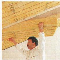
Nach dem Verlegen der FLAMMEX N-Folien sichern die Butyl-kautschuk-Bänder ISObutyl die Luftdichtigkeit zwischen den Bahnen und den übrigen Bauelementen.
